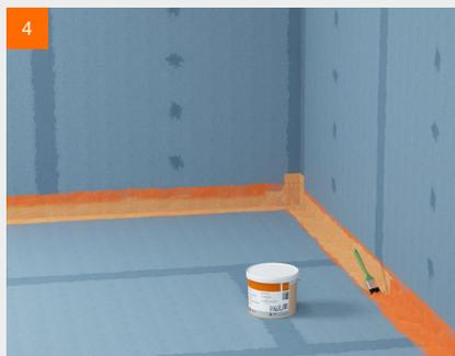
4 Aplicar directamente película impermeabilizante fermacell™ sobre la banda de sellado
