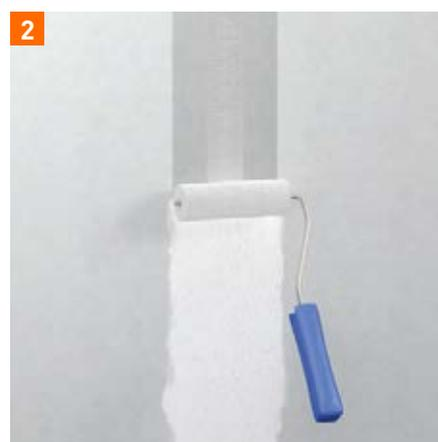
Aplicación del pegamento para sellado de juntas **fermacell HD**
