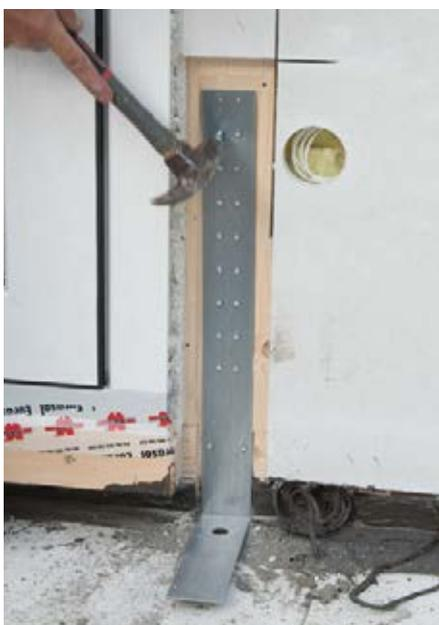
Montaje del anclaje a la solera para evitar el levantamiento. En la foto falta de anclar a solera.
