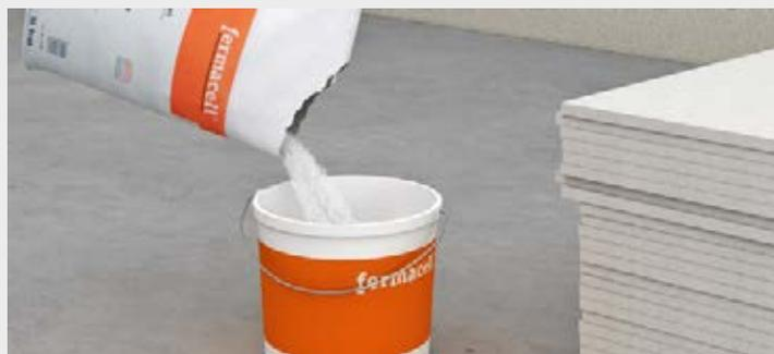
Vertido de la pasta de juntas fermacell en un cubo con agua limpia, dejar reposar posteriormente
