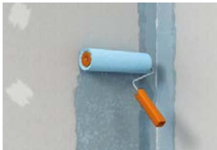
Aplicación en toda la superficie de la imprimación **fermacell**. Tiempo de secado mínimo 2 horas
