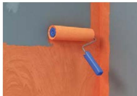
Aplicar película impermeabilizante mediante rodillo en toda la superficie (2 manos, espesor total  $\geq 0,5$  mm), en caso de requerirse. Tiempo de secado mínimo 2 horas.
