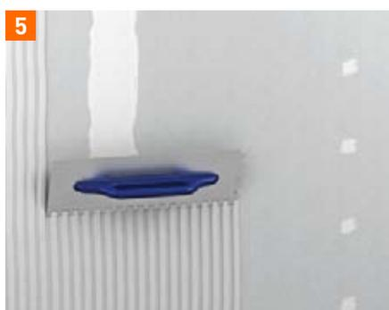
Aplicación del mortero ligero **fermacell** HD de 5-6 mm de espesor (capa base)
