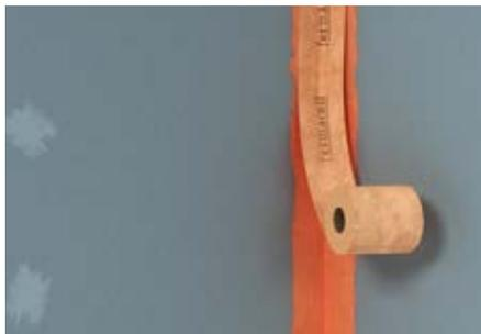
Aplicación de la película impermeabilizante **fermacell** en los encuentros y esquinas y pegado de las bandas de sellado sobre la película en fresco. Se debe aplicar nuevamente la película para cubrir la banda de sellado. Tiempo de secado mínimo 1 hora.
