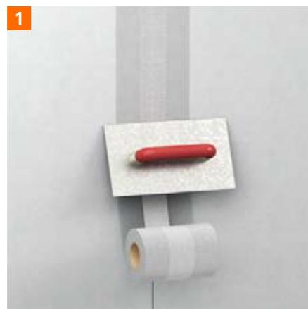
Aplicación de la cinta para el refuerzo y sellado de juntas **fermacell HD**
