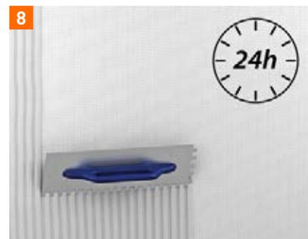
Aplicación de la capa de acabado (2-3 mm) del mortero ligero **fermacell** HD (o producto compatible) una vez seca la capa base
