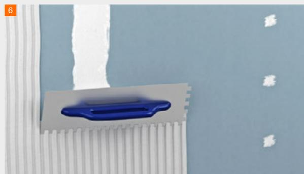
Extensión del mortero ligero fermacell™ HD en 5–6 mm de espesor para la capa base
