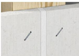
Junta enmasillada con pasta de juntas. Ancho de juntas en función de espesor de placa (ver página 82)
