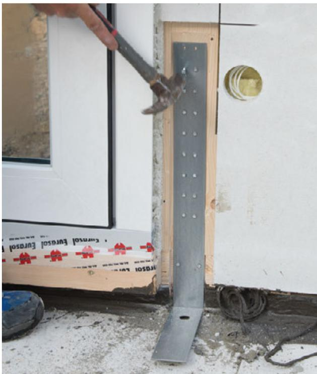
Montaje del anclaje a la solera para evitar el levantamiento. En la foto falta de anclar a solera.
