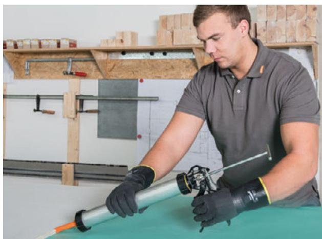
Aplicación del pegamento de juntas fermacell™ con la bolsa de 580 ml
