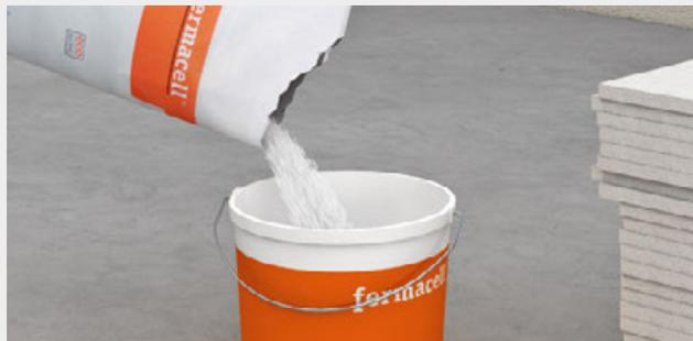
Vertido de la pasta de juntas fermacell™ en un cubo con agua limpia, dejar reposar posteriormente
