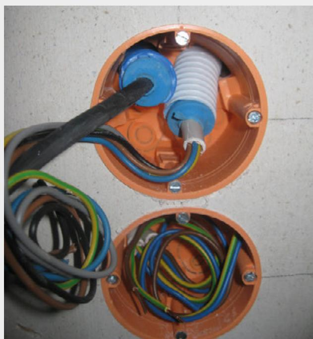
Ejemplo de sellado de los tubos corrugados para el paso de cableado hacia el exterior.
