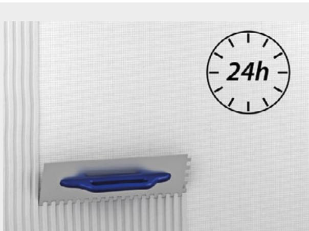
Aplicación de la capa de acabado del mortero ligero fermacell™ HD una vez secado el mortero base (variante A).
