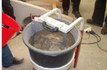
Mezcla del mortero expansivo fermacell™
