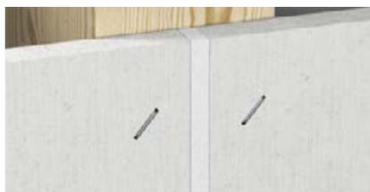
Junta enmasillada con pasta de juntas. Ancho de juntas en función de espesor de placa (ver página 82)
