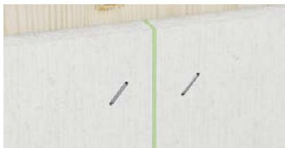
fermacell™ junta pegada, ancho de juntas  $\leq 1$  mm
