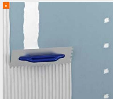
Extensión del mortero ligero fermacell™ HD en 5–6 mm de espesor para la capa base
