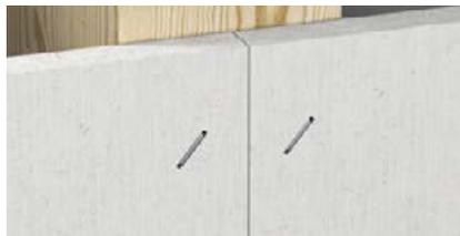
Placas a testa, ancho de juntas  $\leq 1$  mm
