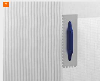
Embebido de la malla de fibra de vidrio fermacell™ HD en la capa base
