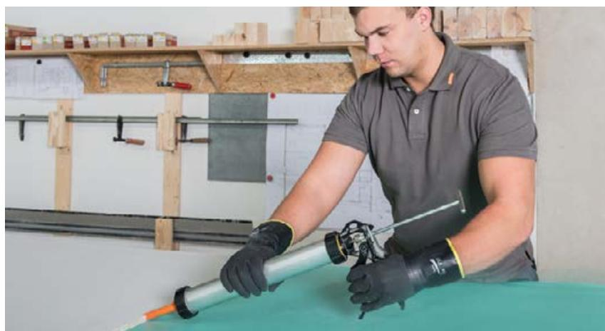
Aplicación del pegamento de juntas fermacell™ con la bolsa de 580 ml
