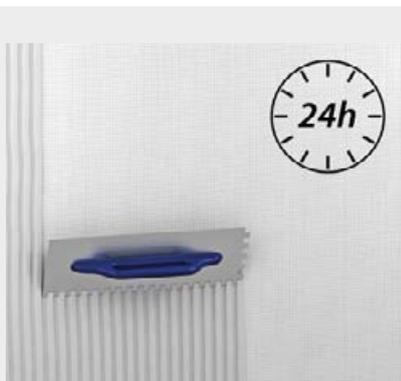
Aplicación de la capa de acabado del mortero ligero fermacell™ HD una vez secado el mortero base (variante A).
