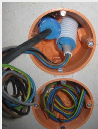
Ejemplo de sellado de los tubos corrugados para el paso de cableado hacia el exterior.
