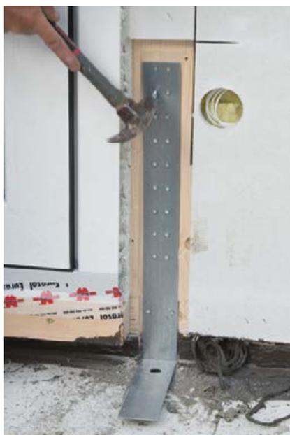
Montaje del anclaje a la solera para evitar el levantamiento. En la foto falta de anclar a solera.
