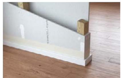
Entramado de madera fermacell™ (Detalle jamba, junta pegada)
