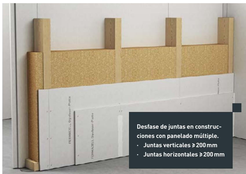
**Desfase de juntas en construcciones con panelado múltiple.**
