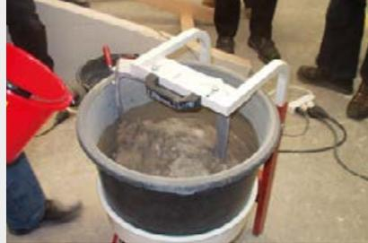
Mezcla del mortero expansivo fermacell™
